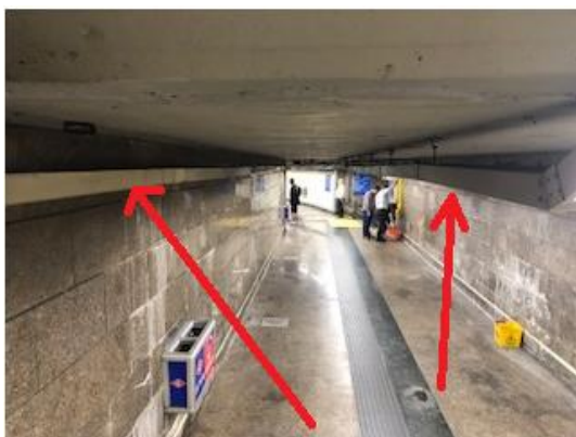
Conducciones de circuitos: bandeja IESA y canaleta lateral
