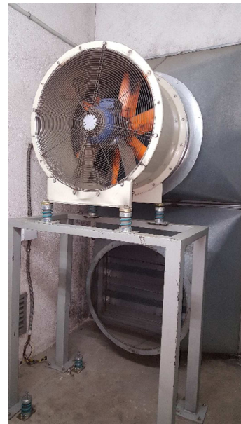
Imagen 6: Ventilador instalado.
