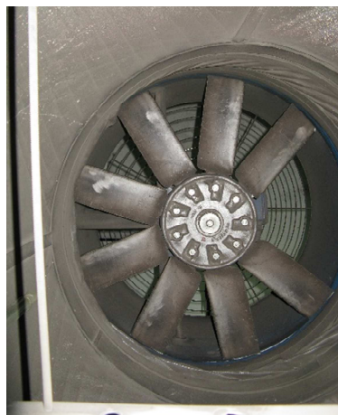
Imagen 2: Rotura en aspa ventilador
