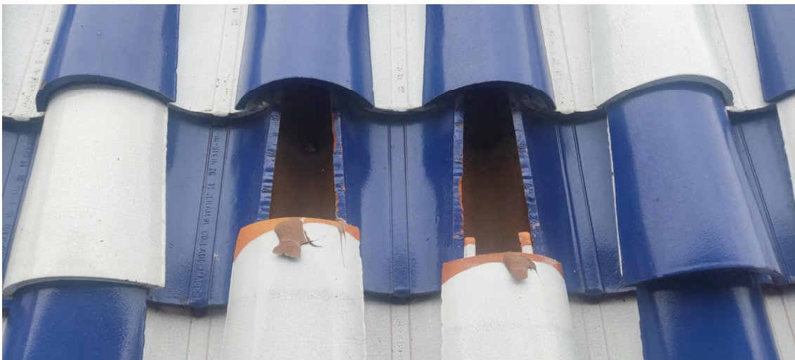
Deslizamientos y pérdidas de piezas en los faldones.
